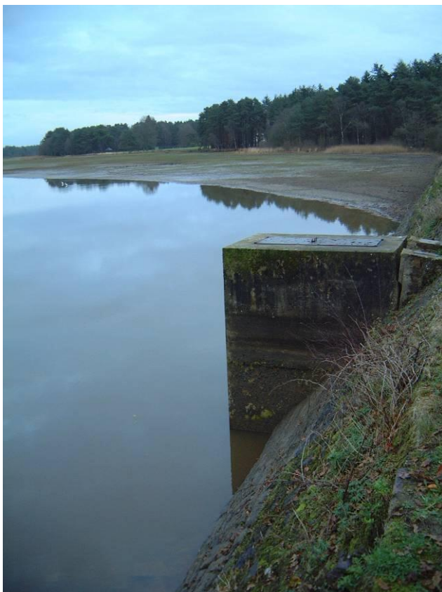
Moine permettant la vidange d'un étang - CRPF
