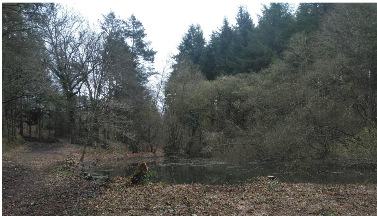
Différents aperçus du chantier à la fin des travaux
