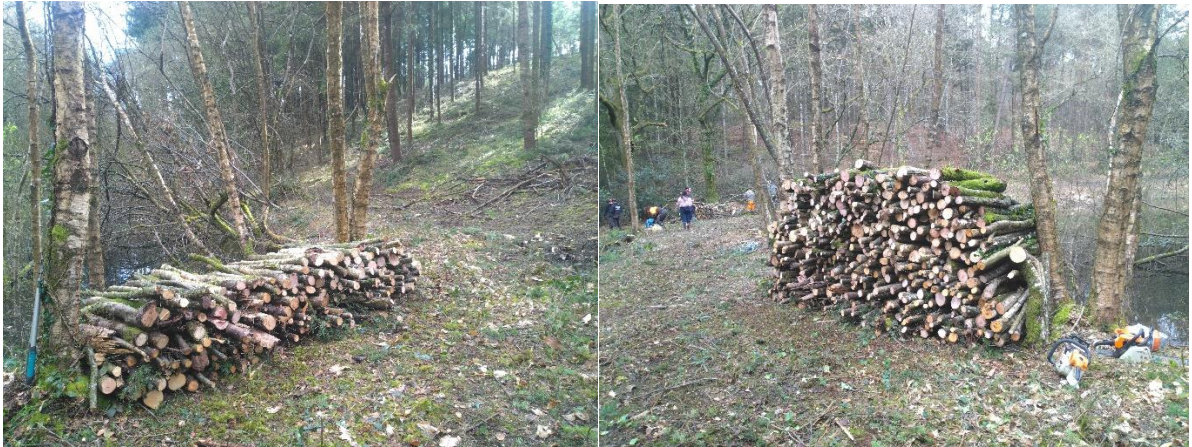
Le futur abri à amphibien (tritons, salamandres, crapauds...) en phase terrestre prend forme au fur et à mesure de l'avancée du chantier
