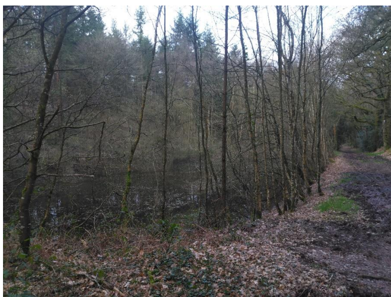
Etat du chantier avant travaux (vue de l'Est)
